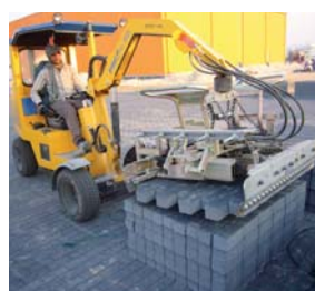
VM-203: Uchycení a seřazení obdélníkové dlažby do vazby
